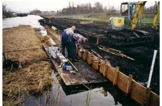
Aanleg van een schoeiing met platothout. Kwekerij J. Been, Aalsmeer-Oost (november 2000).
