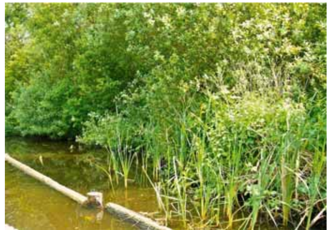
Een oeverbescherming met drijfpalen bij Topsvoort (1998).
