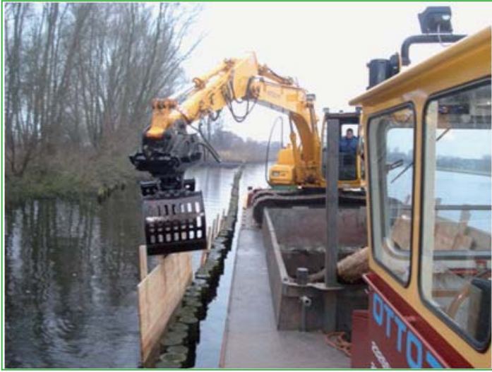
De firma Otto plaatst schotten achter de bestaande palenrij.
