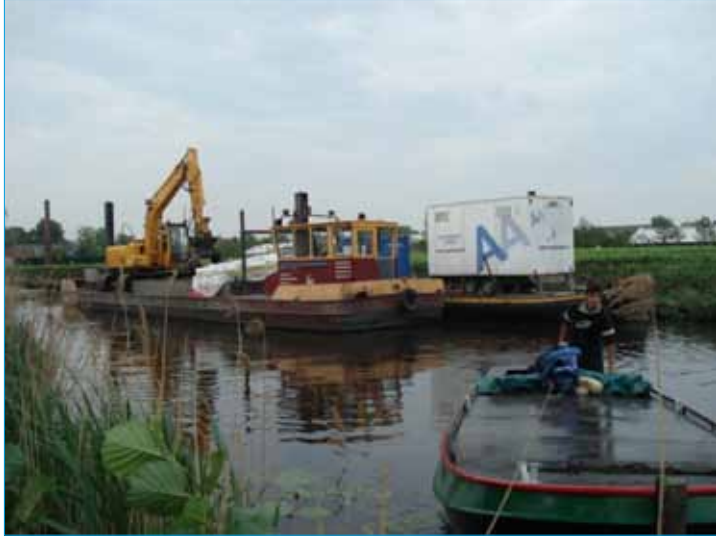
Asbestsanering bij project Spaargaren
